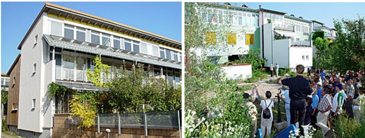
ゲロルズエッカー・エコ住宅地。南面の窓を大きくとり、冬の日差しを有効利用できるように作られている。ひさし上の太陽熱温水器で年間に必要な給湯エネルギーの約半分をまかなう(左)、建設10周年の記念見学会でエコ建築を説明するルフラー教授(右)
